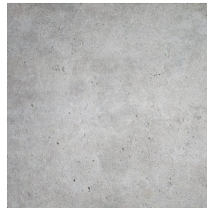
Beton (gevels, wanden vloeren)
